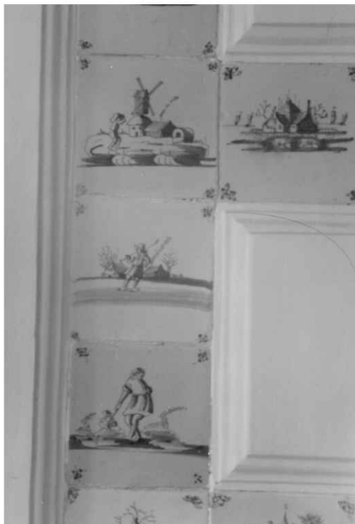
18. Gardzienice, pomieszczenie parteru oficyny pd. dekorowane płytkami z Delft, fot. A. Socko.
